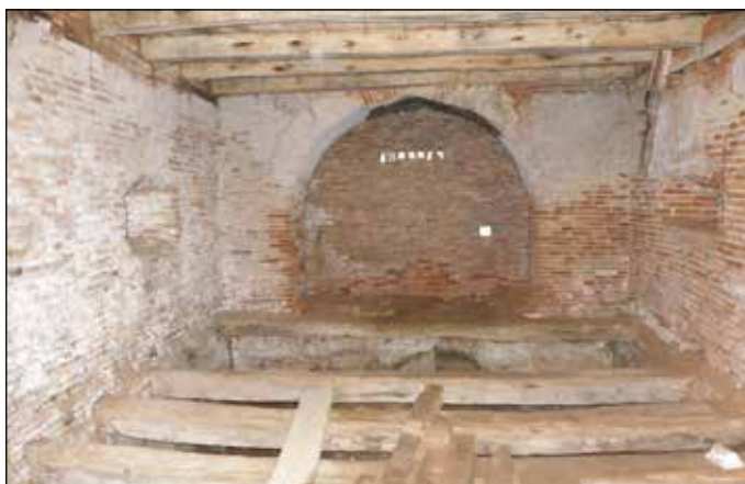
■ Foto 11. Alma Vii, Turnul Slăninii, vedere din interior înainte de restaurare © MET ■ Photo 11. Alma Vii, Larder Tower, view from inside before conservation © MET
