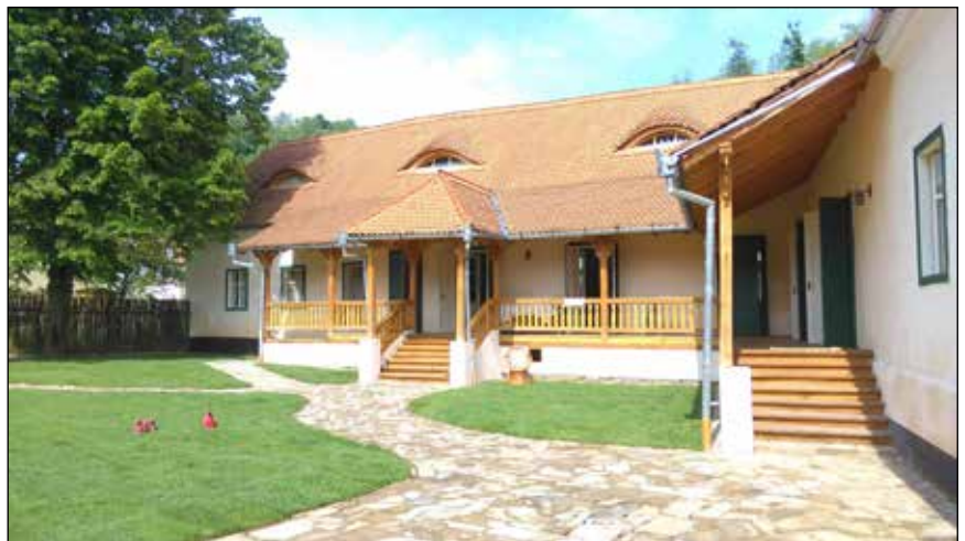
■ Foto 20. Richiş, Casa Richiş după restaurare © MET
